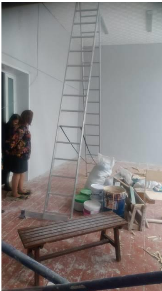
(частичный ремонт потолка)
